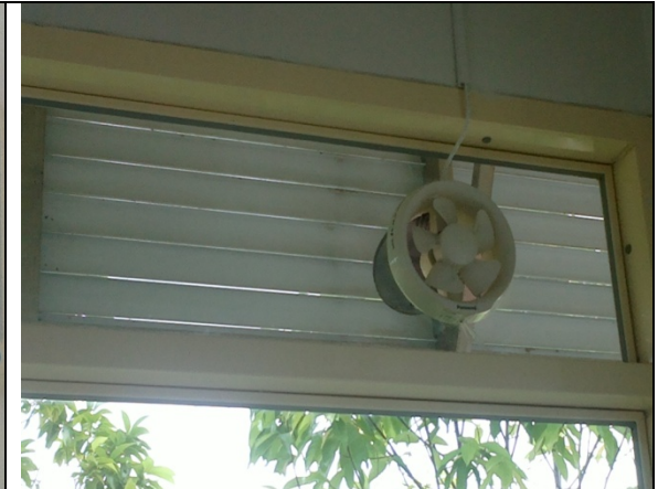
ปิดพัดลมดูดอากาศในห้องที่ไม่ได้ใช้ งาน
