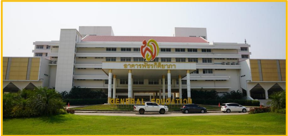
ภาพที่ 13 สำนักส่งเสริมและบริการวิชาการ อาคารพัชรกิติยาภา (อาคาร7)
