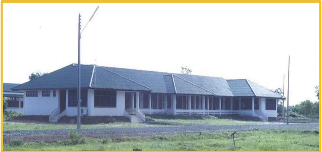
ภาพที่ 10 สำนักส่งเสริมการเรียนรู้เดิม (อาคารเรียนชั่วคราว)
